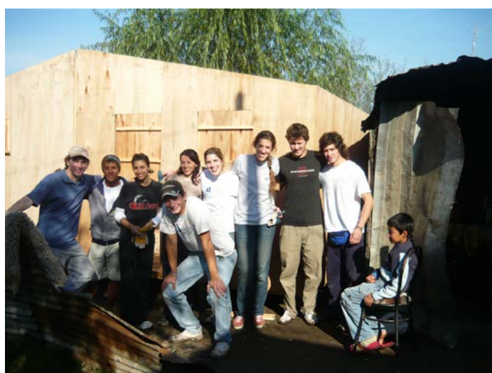
Un Techo Para Mí País – Construcción Mayo 2009
